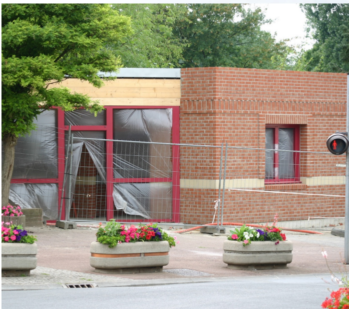
Construction du local « Yves BLAS », en extension de l'Église. Ce local subventionné par le Conseil Général servira au catéchisme.
