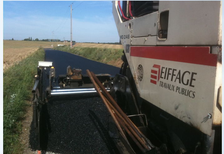
Le nouveau chemin de Cauroir interdit aux poids lourds de plus de 3,5 tonnes
