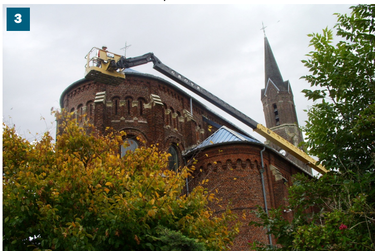
Remplacement des gouttières de l'Église
