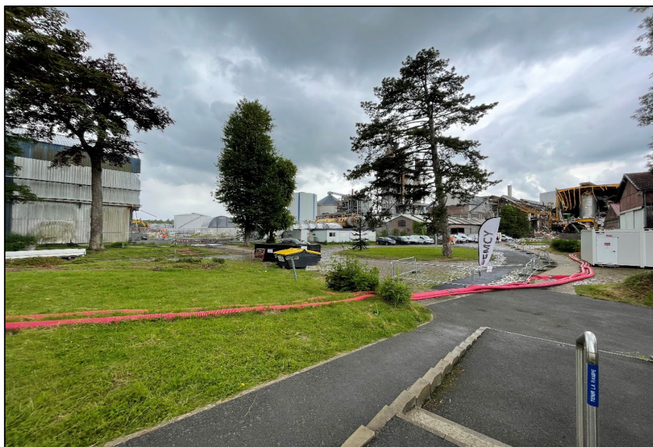
Photographie du site de la sucrerie TEREOS (déconstruction en cours)
