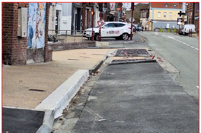
Nouvel emplacement de l'arrêt de bus avec bordures P.M.R.
