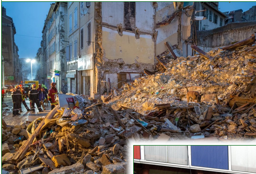
Effondrement d'un immeuble
